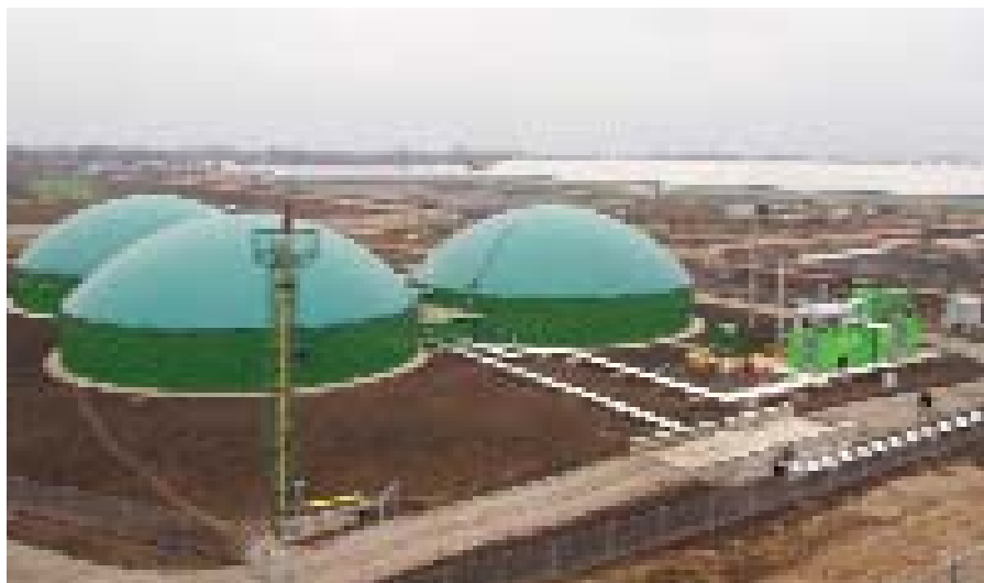
Первая украинская теплоэлектростанция, работающая на биогазе
